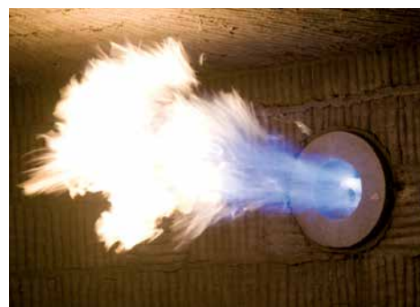
Flammenbild während der Aufheizphase. Nach Erreichen der Betriebstemperatur > 850°C werden die Brenner zum Erreichen niedriger NOx-Werte flammenlos betrieben. Flame shape during heating. To ensure lowest NOx-emissions the burners will be switched to flameless mode above 850°C.
